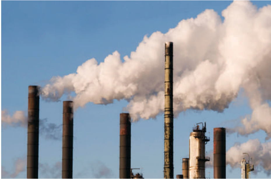
■ الشكل 14-8 الرماد المتصاعد من المداخن نتيجة ثانوية لاحتراق الفحم. ويمكن استعمال مرشحات الترسيب الكهروستاتيكية لتقليل هذا الرماد.
