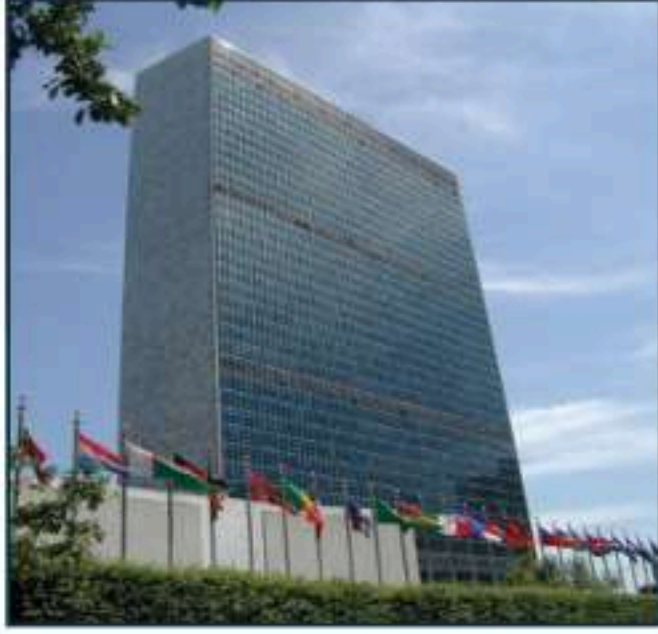
▲ مبنى هيئة الأمم المتحدة
