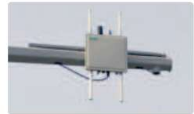
شكل 7.6: وحدة الاتصال على جانب الطريق (RSU)
