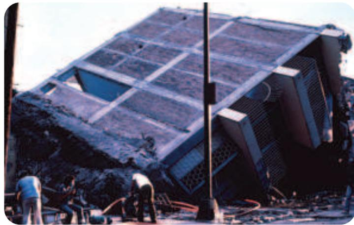
الشكل 34-6 تدمرت المباني المتوسطة الارتفاع في أثناء حدوث الزلزال؛ لأن تردد اهتزازات هذه المباني يساوي تردد اهتزازات الأمواج الزلزالية.
