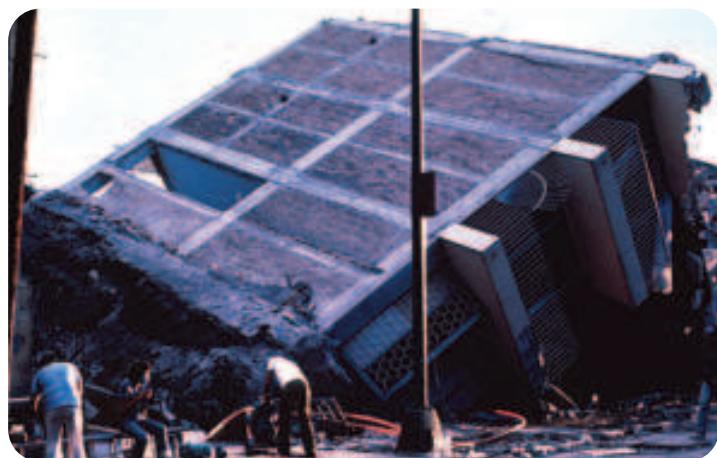
الشكل 34-6 تدمرت المبني المتوسطة الارتفاع في أثناء حدوث الزلزال؛ لأن تردد اهتزازات هذه المبني يساوي تردد اهتزازات الأمواج الزلزالية.
