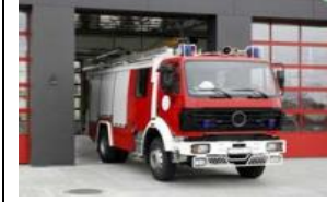
Fire station محطة الاطفاء
